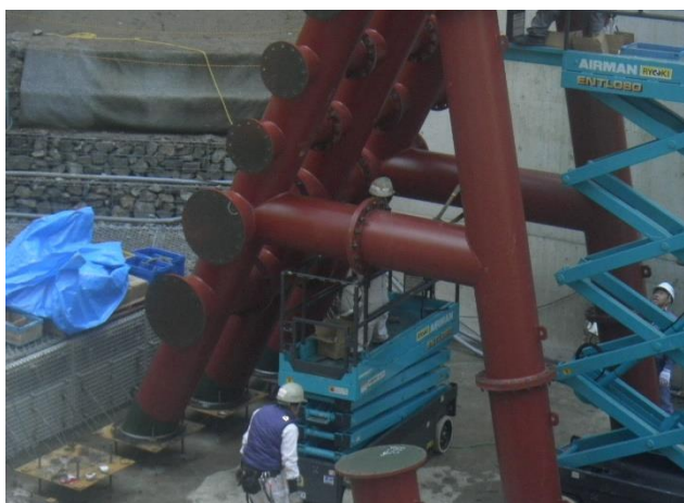
高所作業車によるボルト締め
