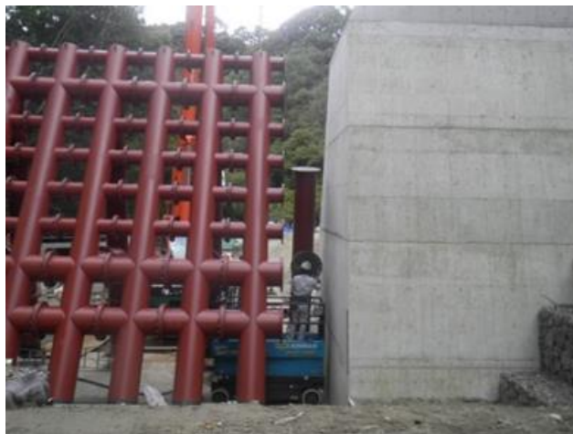
高所作業車によるボルト締め
