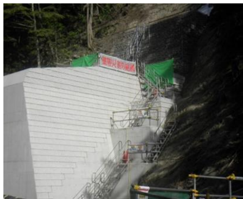
昇降設備設置(本堤部)
