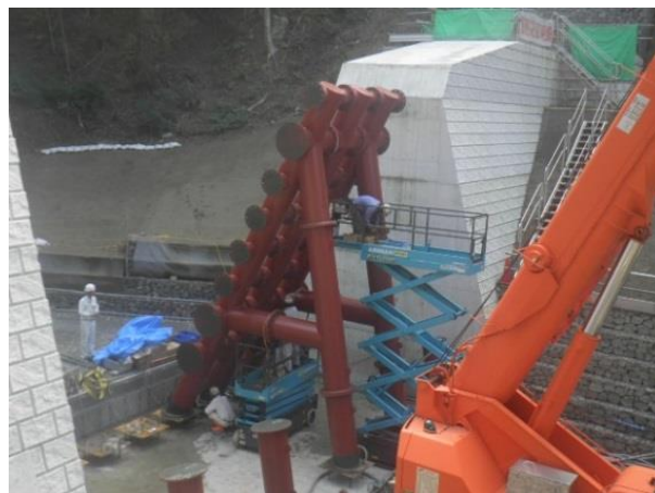
高所作業車によるボルト締め
