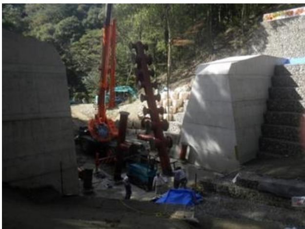
高所作業車によるボルト締め
